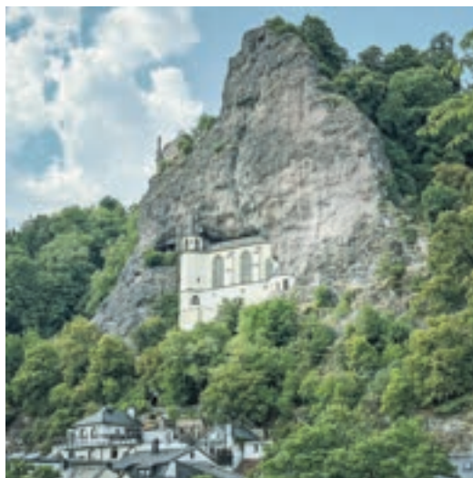
Die Kirche in Idar-Oberstein ist direkt in den Fels hineingebaut worden. Foto: Brüggemann / KNA-Bild
