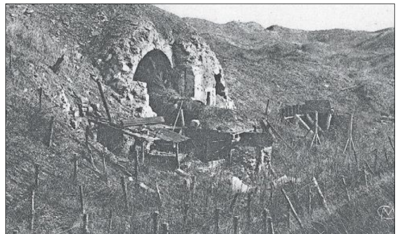
▲ Die Festung Fort Souville kurz nach Ende des Ersten Weltkriegs. Die Anlage war während der Schlacht um Verdun in heftige Kämpfe verwickelt und wurde durch Artilleriebeschuss fast vollständig zerstört. Foto: gem
