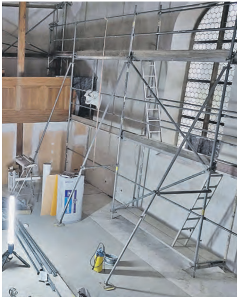
Da waren die Sanierungsarbeiten noch in vollem Gang: Blick ins Innere der evangelischen Kirche von Dörrmoschel.
