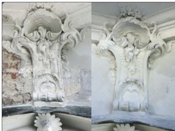
◀ Ein Stuckornament aus dem Jahr 1715 vor und nach der Rekonstruktion durch den Restaurator.
