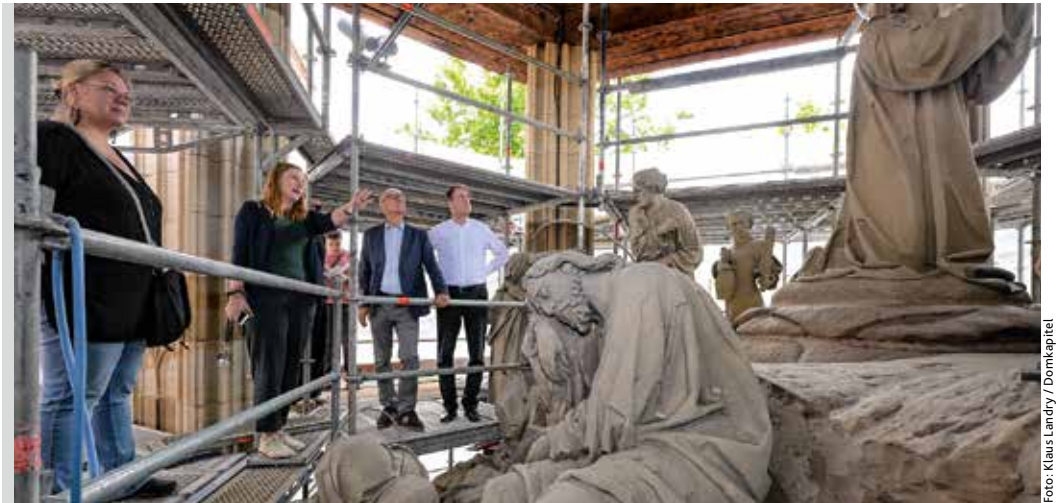
Umhüllt und eingerüstet: In den kommenden Monaten wird der Ölberg an der Südseite des Speyerer Doms saniert. Die Planungen wurden jetzt der Öffentlichkeit vorgestellt.
