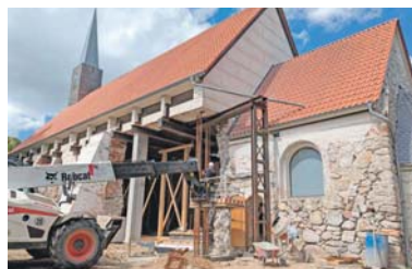
An die Kirchenseiten werden Säulen gebaut.
